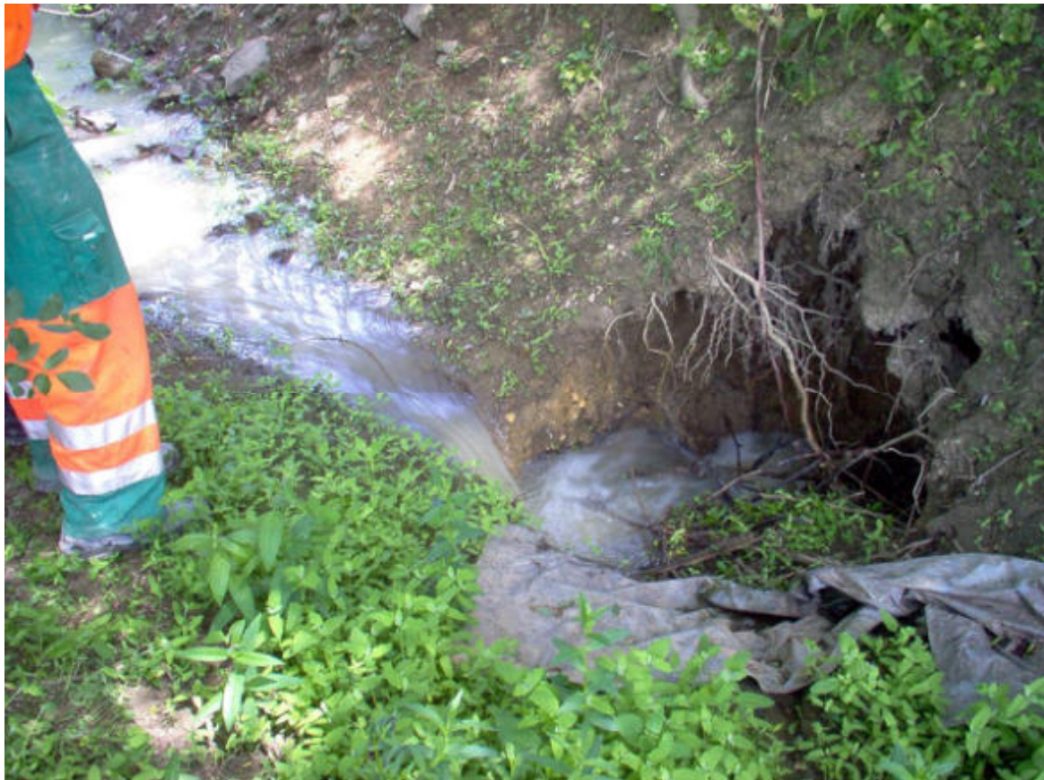
Photo 6 : Perte actuelle du Pas-Sicard en aval du Pont d'Augrain - Mai 2011
