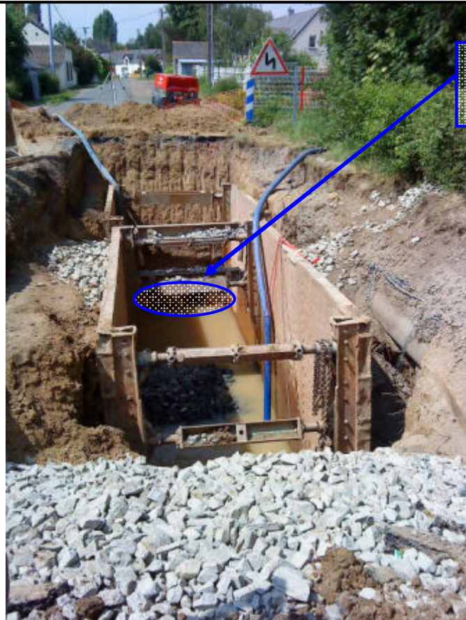
Photo 1 : Fouille à Augrain pour passage d'une conduite sous le Pas-Sicard, Mai 2011
