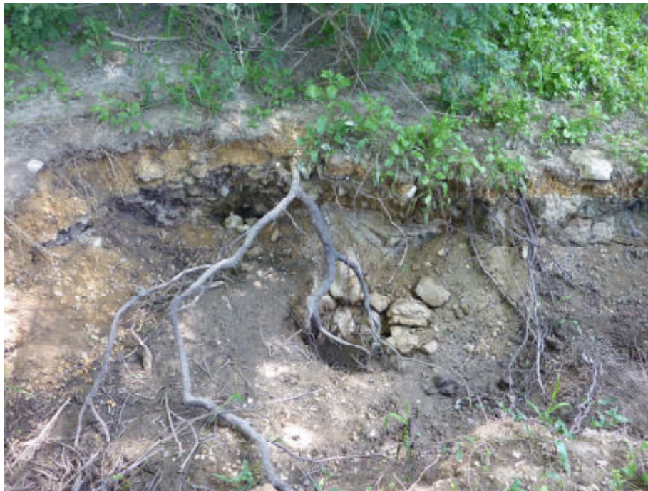
Figure 27 : Exemple de zone d'émergence temporaire dans le lit de l'Isac
