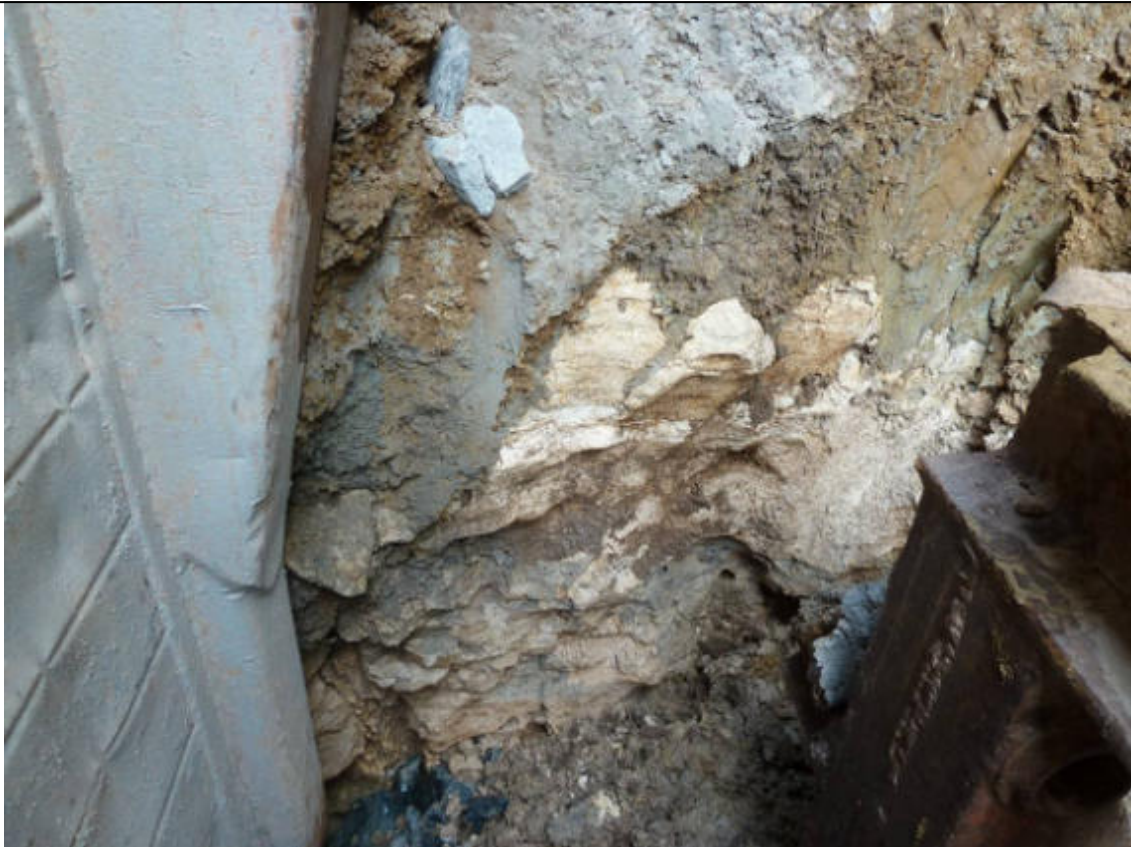
Photo 3 : Vue de détail des calcaires fracturés dénoyés avec pompage, mai 2011
