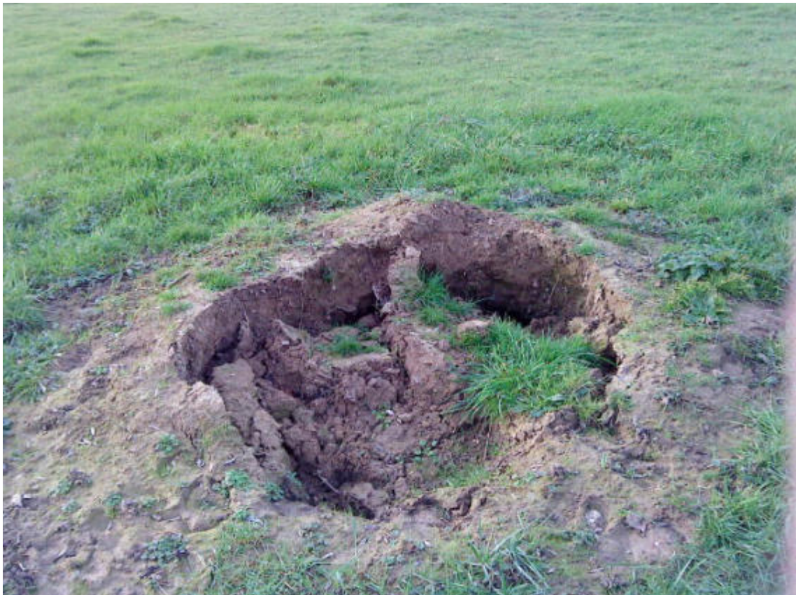
Photo 12 : Nouvel effondrement après un rebouchage à la Chutenaie – Janvier 2012
