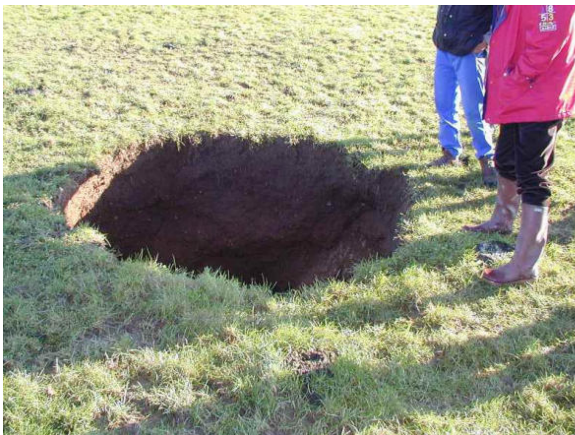
Photo 10 : Effondrement aux Petits Frênes (cliché SDAEP 44 - Décembre 2001)
