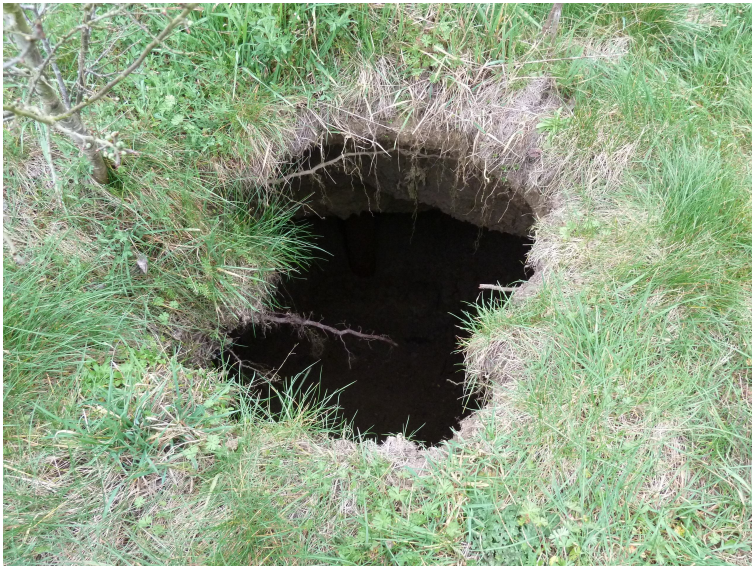
Formation d'un effondrement Lieu-dit Augrain
