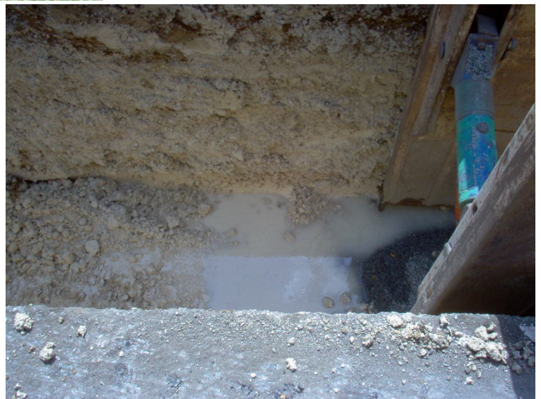
Marnes blanches D39 reliant le lieu-dit Augrain au bourg de Saffré
