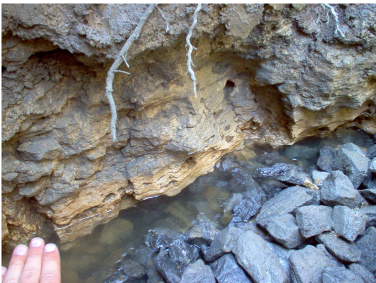
Calcaire marin observé avec venue d'eau importante Lieu-dit Augrain
